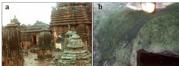
Fig. 1 Monumenti in pietra interessati dal biodeterioramento: a) Complesso dei templi Lingaraj a Bhubaneswar, Orissa, India; b) Cubicolo illuminato da luce artificiale nelle Catacombe di Domitilla, Roma, Italia.
